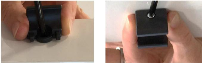
Den ersten Deckenclip montieren Sie mit einem Abstand von 70mm vom Anlagenbeginn, den letzten Deckenclip 70mm vom Anlagenende. Die dazwischenliegenden Deckenclips werden gemittelt und ca. alle 500mm gesetzt.
